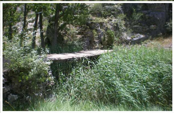
FOTO 6. Puente del Masegosillo. Invasión del cauce por carrizo
